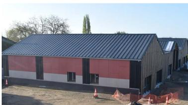
Les travaux de construction ont débuté en juin 2023. La pose de la toiture végétalisée, du bardage extérieur et de l'isolation intérieure sont en cours.
