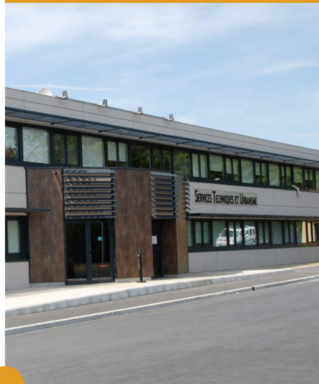
En 2018, un service urbanisme intercommunal est créé et implanté à Coulommiers, au 17 boulevard de la Marne
